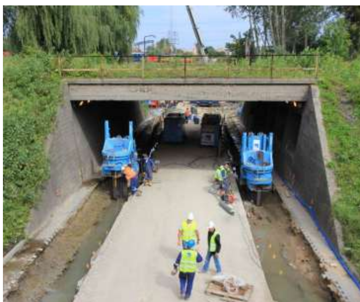
Fot. 1. Współczesny przykład wykorzystania technologii wciskania do wykonania palisady w trudnych warunkach - Warszawa, ul. Dźwigowa (z archiwum Aarsleff Sp. z o.o.)
