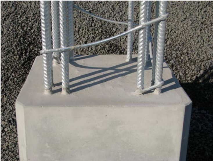
Fot. 7. Przekrój typowego żelbetowego prefabrykatu palowego
