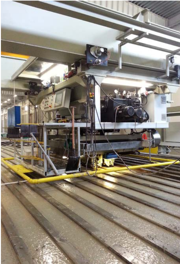
Fot. 4. Betonowanie prefabrykatów z wykorzystaniem betonowej mieszanki samozagęszczającej
