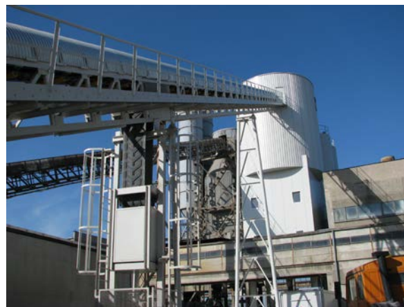
Fot. 1. Węzeł betoniarski
