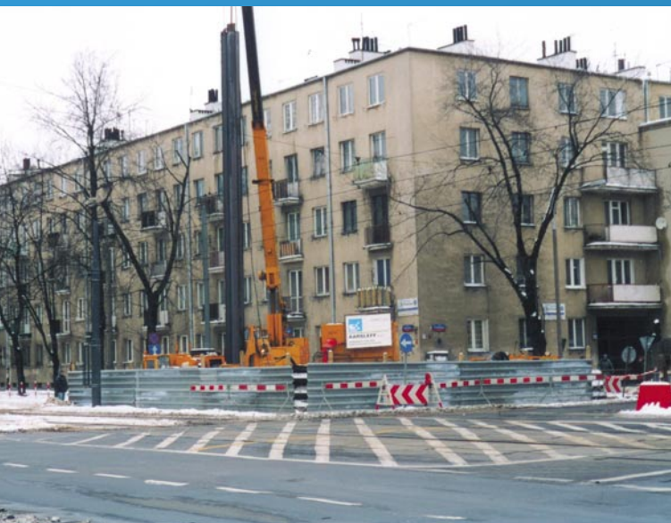
Instalacja komory KO1 przy ul. Popiełuszki w Warszawie
