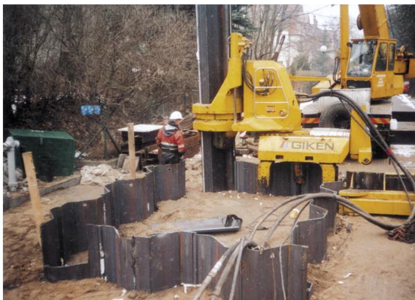
Ta sama komora w trakcie realizacji w Sopocie. Plac budowy zajmuje pełną szerokość ulicy
