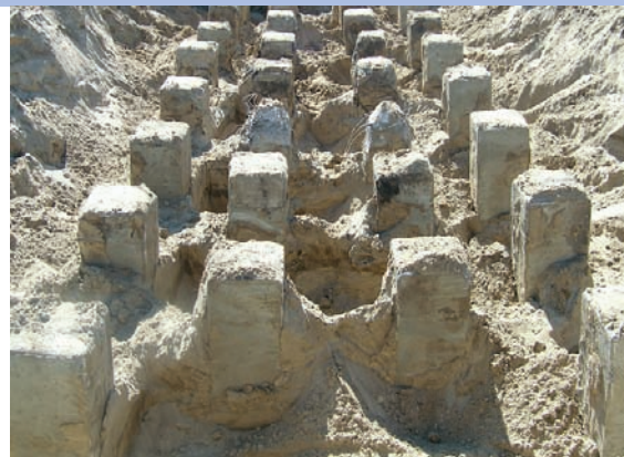
Gotowy fundament palowy filara mostu M-1
