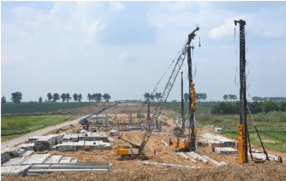
Rysunek 6. S5. Roboty palowe. Na budowie pale magazynowane na platformie roboczej.
