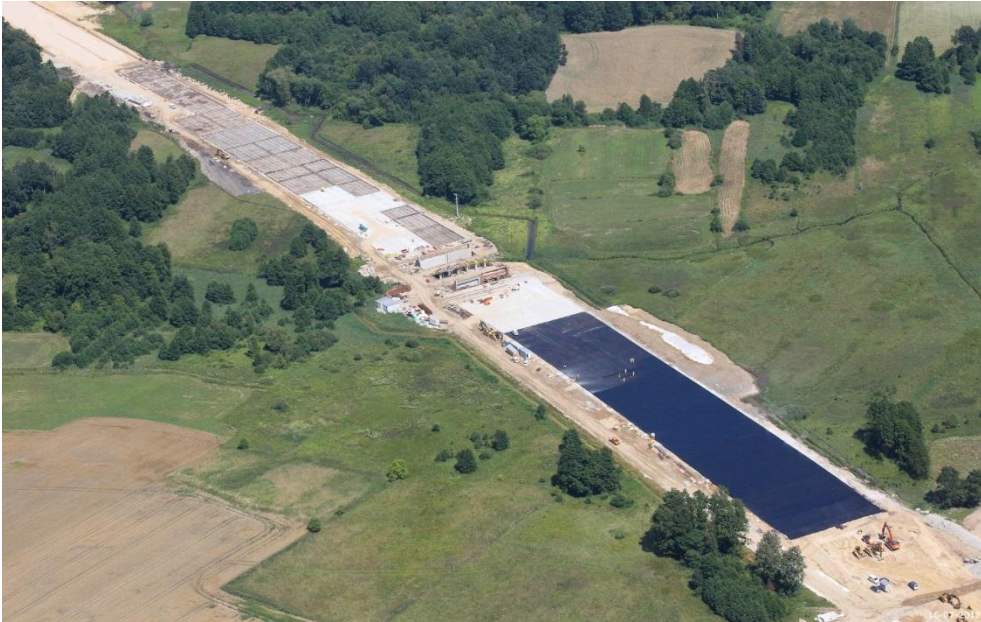
Rysunek 9. S6. Roboty budowlane po zakończeniu palowania.
