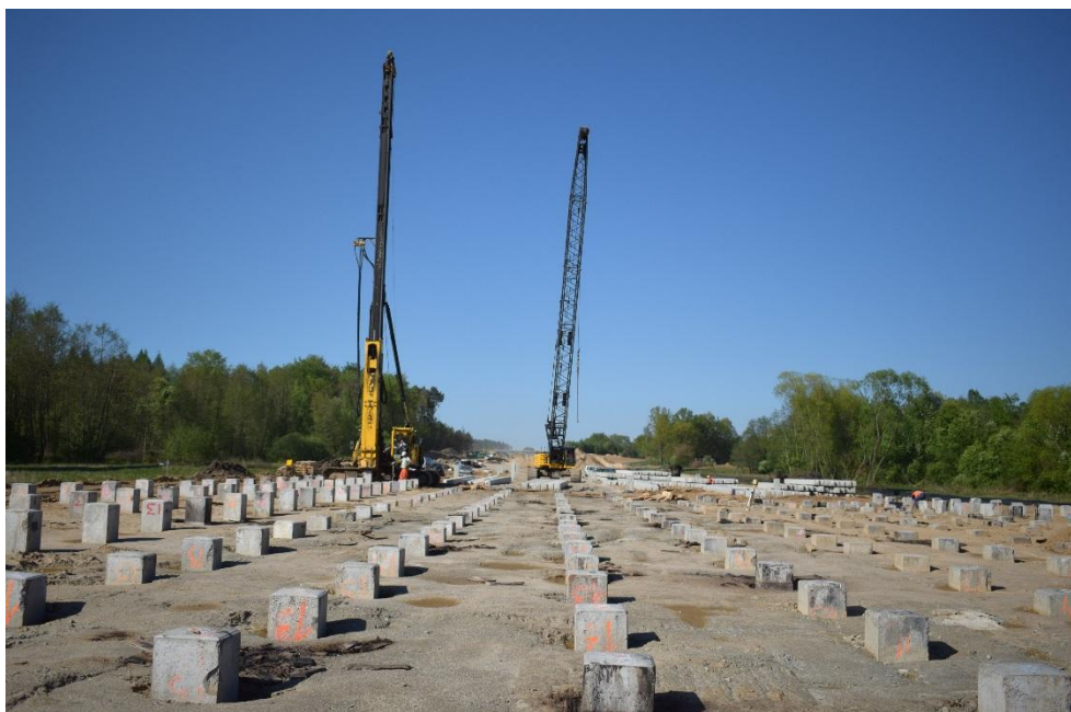
Rysunek 7. S6. Roboty palowe. Czysty plac budowy.
