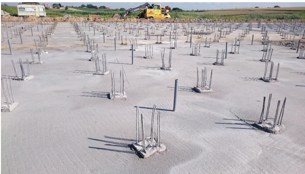
Rysunek 8. S5. Rozkute głowice pali.
